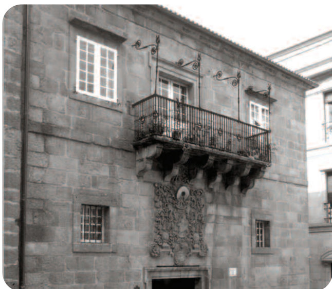
FACHADA DO EDIFICIO Á PRAZA MAIOR
