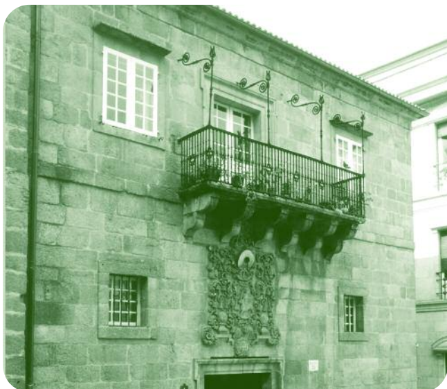
FACHADA DO EDIFICIO Á PRAZA MAIOR
